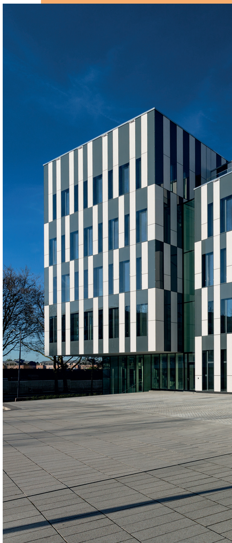
► Immeuble « White Pearl » à Luxembourg
